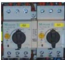
Рис. 1. Автомат электродвигателя
